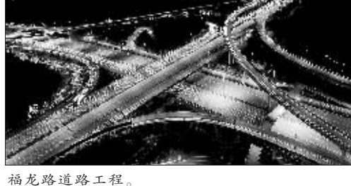
福龙路道路工程。
