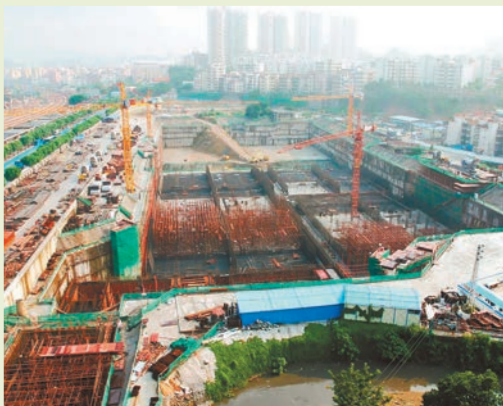
建设中的布吉污水处理厂。
